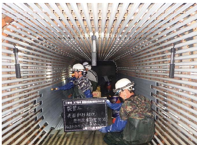
▲老朽化した管路の耐震、改築工事 ※パルテムフローリング工法
