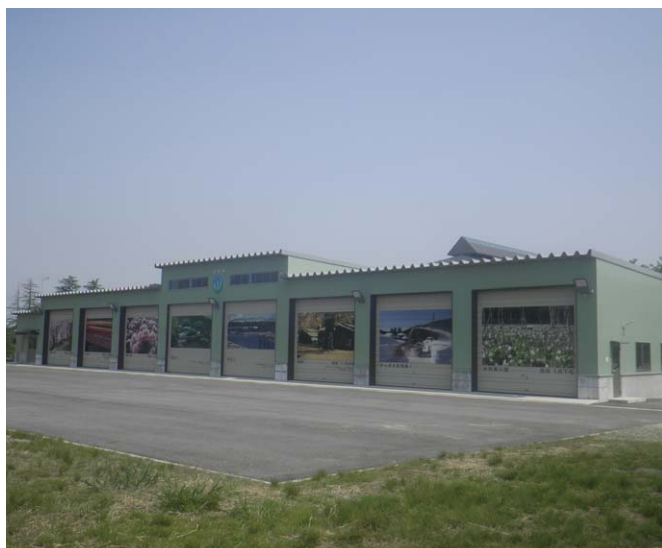
▲除雪車格納庫
