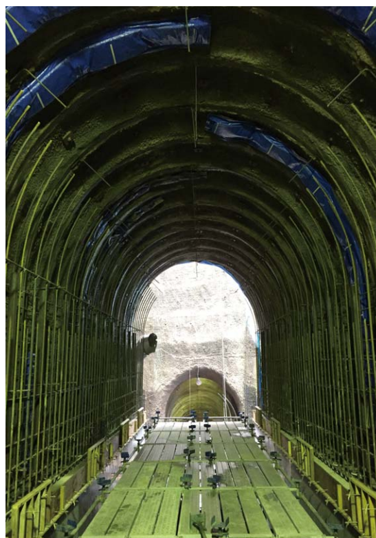
▲水力発電所 放水路トンネル工事
