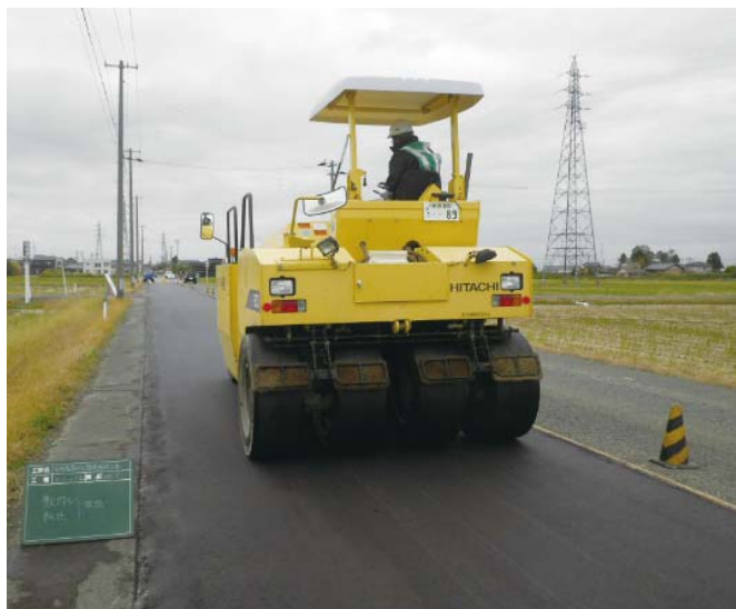
▲舗装転圧状況
