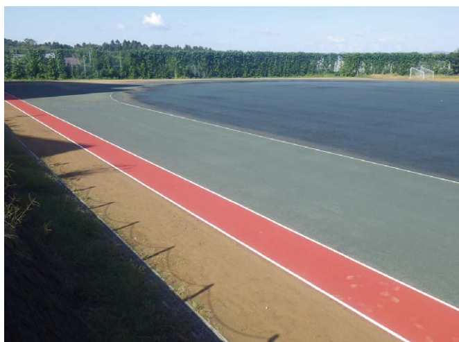
▲長岡高専屋外運動場走路改修工事
