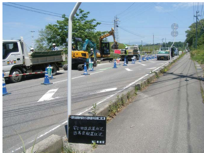
▲ガス本管工事現場
