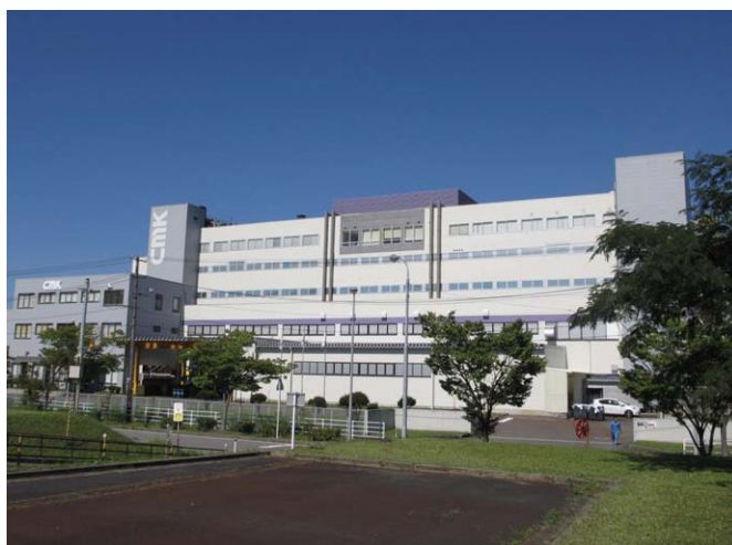
▲蒲原工場 建屋外観
