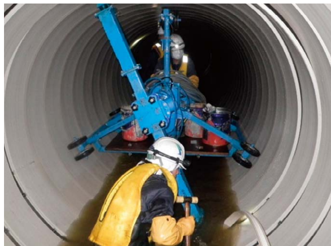
▲老朽化した管路の耐震、改築工事 ※ダンビー工法
