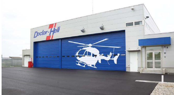
▲【施工例】新潟県ドクターヘリ格納庫オーバーヘッドドア
