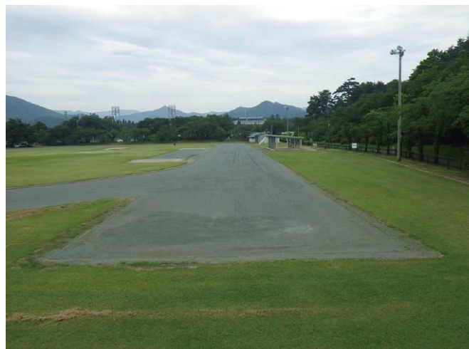
▲五泉市陸上競技場整備工事
