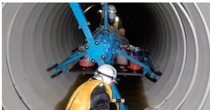
▲老朽化した管路の耐震、改築工事 ※ダンビー工法
