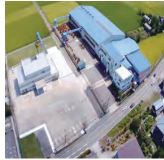
▲本社・第一工場
