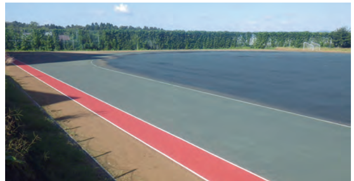
▲長岡高专屋外運動場走路改修工事
