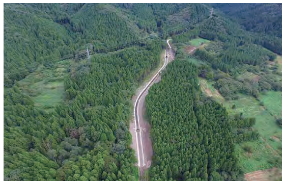
▲大蔵川溪流保全工工事
