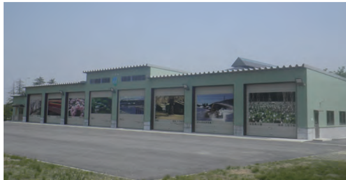
▲除雪車格納庫
